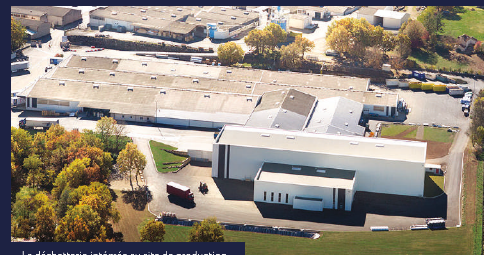
La déchetterie intégrée au site de production
